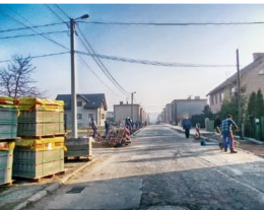
Prace na ul. Słowackiego w Radzionkowie.
